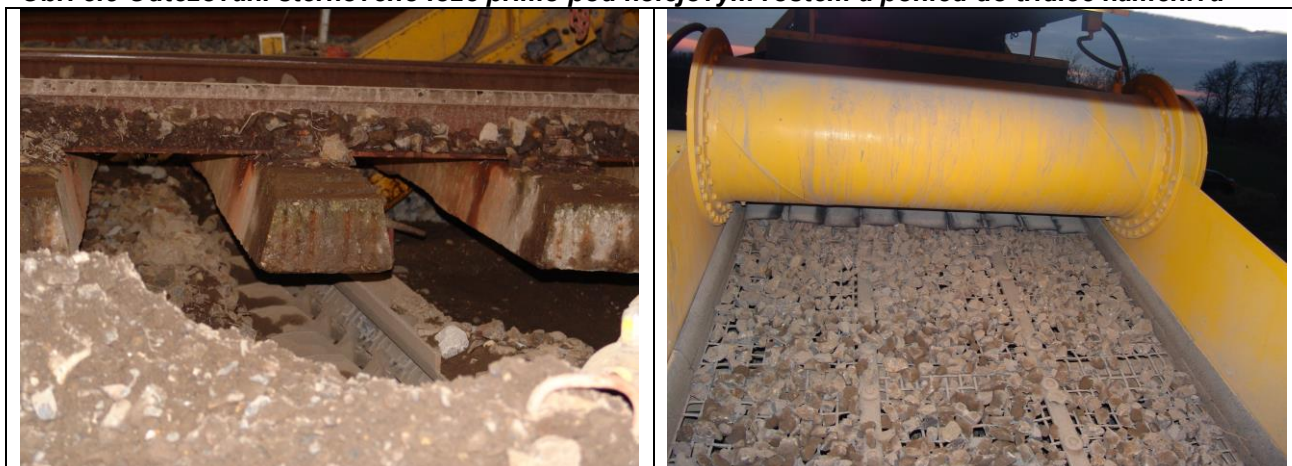
Obr. č.9 Odtěžování štěrkového lože přímo pod kolejovým roštem a pohled do třídiče kameniva
